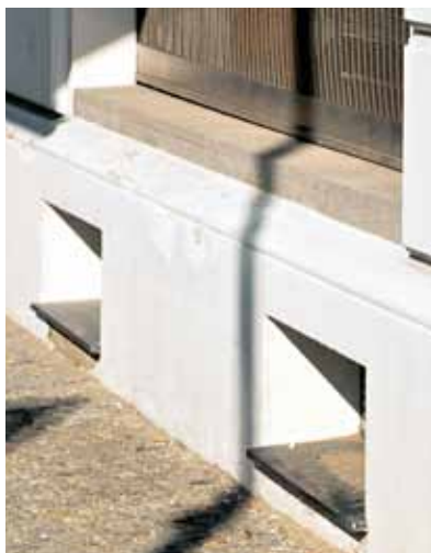
Sockeldämmung mit außen liegender Dämmung. Im Bereich des Spritzwassers wird eine Perimeterdämmung mit entsprechendem Sockelputz angebracht. Die Dämmung der Deckenunterseite wird als Flankendämmung an den Wänden ca. 50 cm nach unten gezogen.
