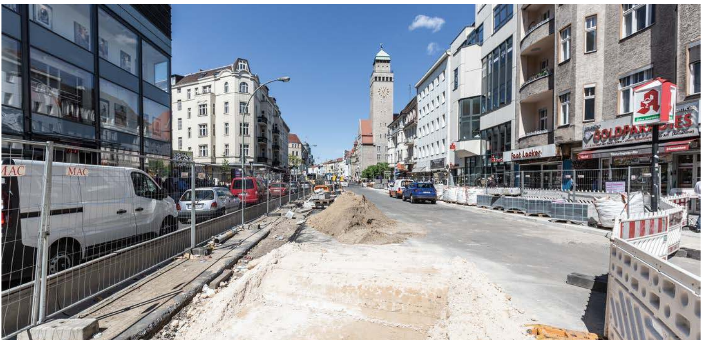
Der Umbau zwischen Anzengruber- und Erkstraße schreitet voran
