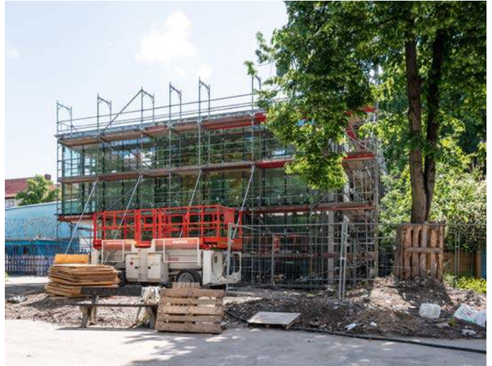
Mehrzweckgebäude der Elbeschule soll 2020 fertiggestellt werden
