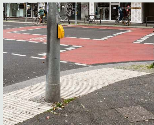
Farbige Fahrbahnmarkierungen erhöhen die Verkehrssicherheit
