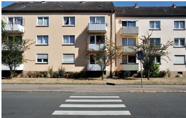
Die Karl-Marx-Straße in Hanau ist eine Anliegerstraße mit vielen Bauten aus den 1950er Jahren und liegt östlich der Kernstadt im Lamboyviertel.
