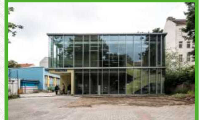
Erneuerung Schulhof Elbe-Schule
