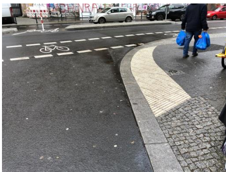
Abb. 10 Taktile Streifen Karl-Marx-Straße Ecke Rollbergstraße
