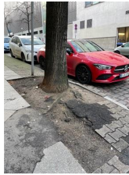
Abb. 8 Südlicher Gehweg, gegenüber: Ein- fahrt Parkhaus
