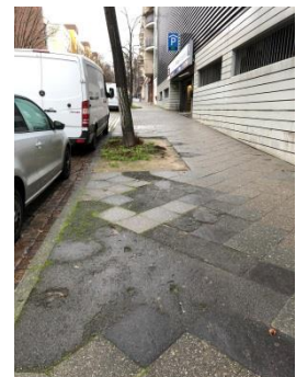
Abb. 6 Nördlicher Gehweg, Höhe Parkhaus
