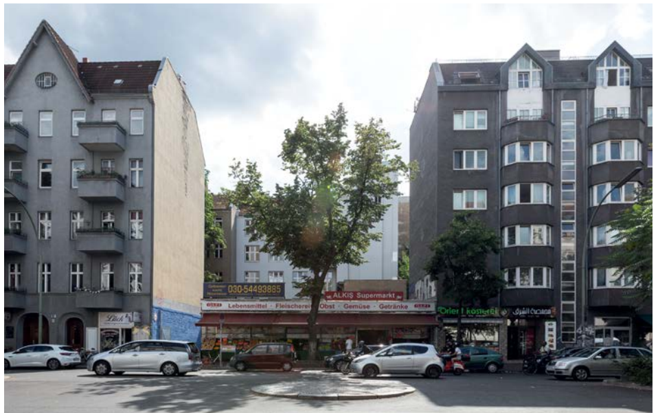
Die eingeschossige Ladenzone wird durch den Neubau eines sechsgeschossigen Wohn- und Geschäftshauses ersetzt
