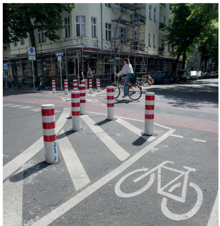
Fertig gebaute Diagonalsperre an der Kreuzung Weser-/ Weichselstraße
