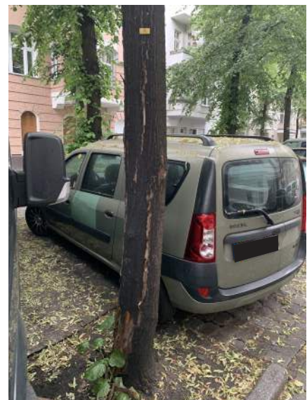
Abb. 7 Baumschäden auf der Mittelinsel
