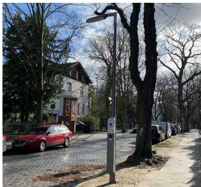
Abb. 84 Umgerüstete Straßenbeleuchtung in Steglitz
