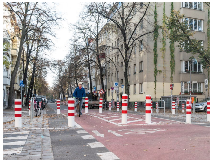
Neu errichtete Quersperre im Kreuzungsbereich Elbestraße
