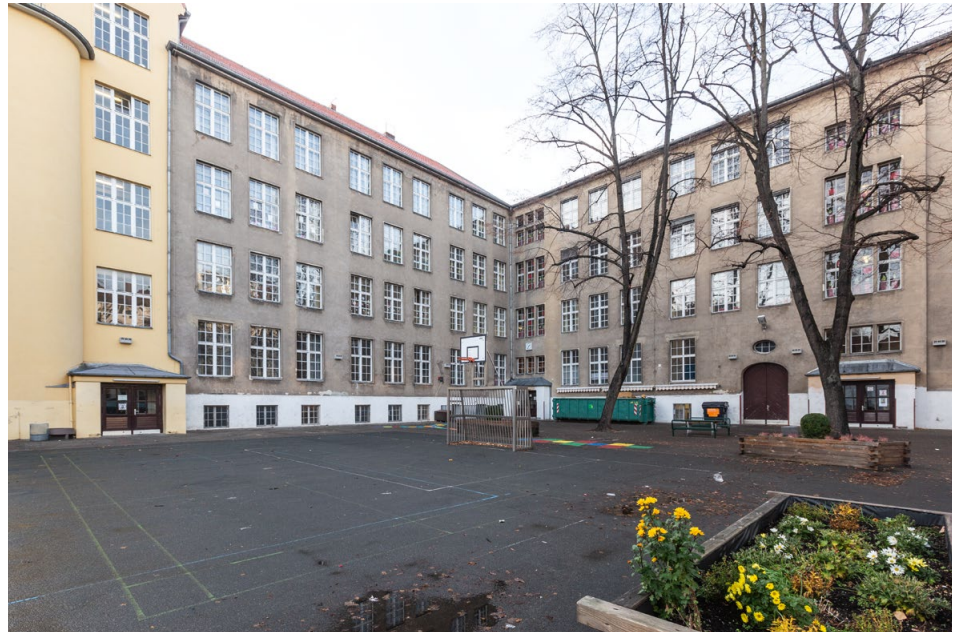
Der Schulhof vor der Sanierung
