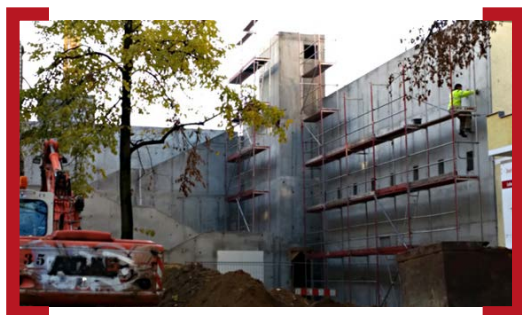
Der Rohbau der Kindl-Trepp © BSG
