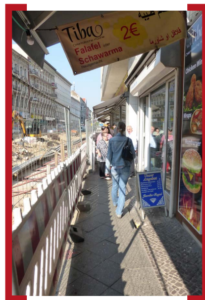
Umbau an der Karl-Marx-Straße schreitet voran © BSG
