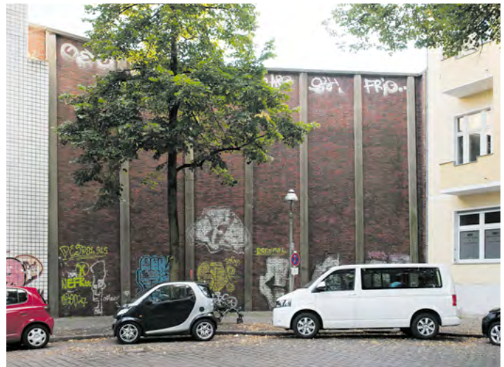
Neckar- /Isarstraße vor dem Umbau
