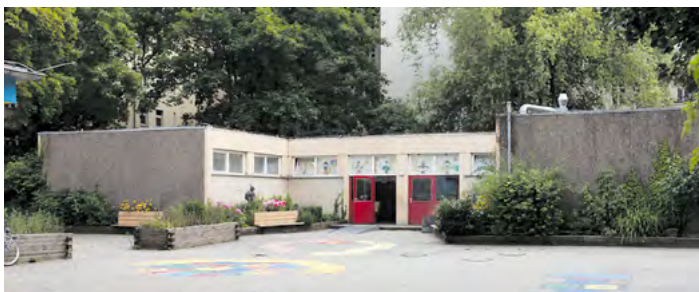
Hortgebäude (Abriss geplant)
