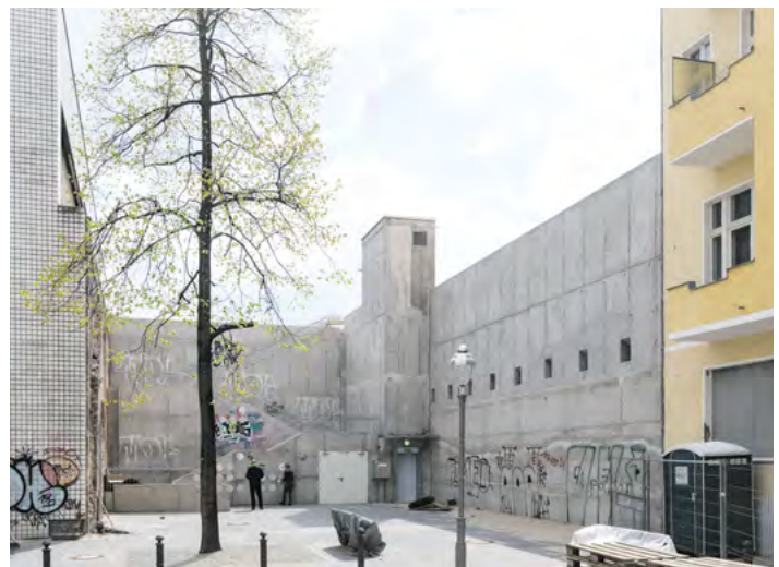
Die neue Treppe verbindet die Neckarstraße mit dem Kindl-Areal
