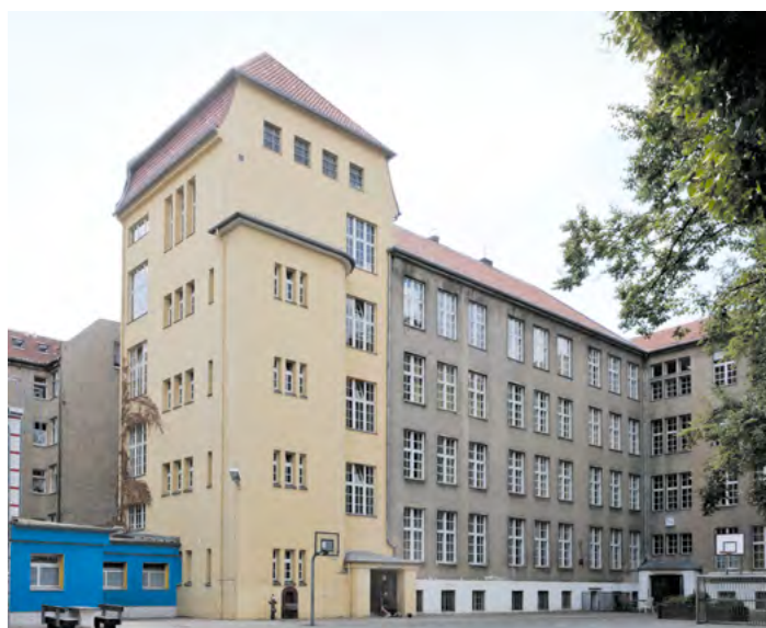
Seitenflügel mit Umkleidetrakt (blauer Anbau)
